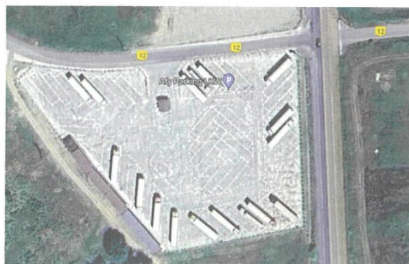
Fig. 18 Intersecție cu DC 12, km 3+725
