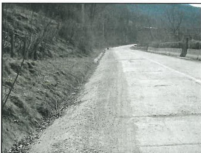
Drumul național 67D propus pentru consolidare are o capacitate portantă necorespunzătoare, durata de exploatare a drumului fiind depășită.
