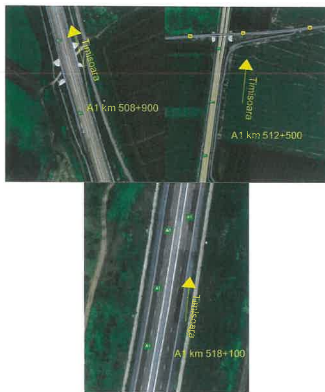
A1 km 508+900 Calea 1, A1 km 512+500 Calea 1, A1 km 518+100 Calea 1
