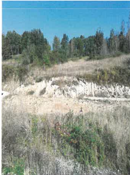
2.17. A1 km 409+600 Calea 1-alunecare taluz de debleu
