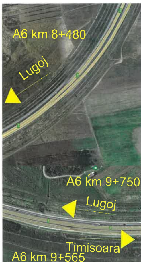
A6 km 8+480 Calea 1, A6 km 9+565 Calea 1, A6 km 9+750 Calea 2
